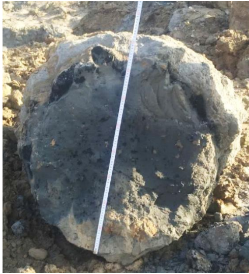
图 5 某黄泛区上部扩大桩体段成桩直径检测
