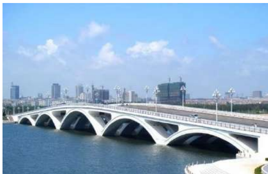
图 12 空腹式连拱桥
