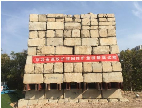
图 2 SZ-5 静荷载试验现场图片 (2022. 11. 3~11. 5)
