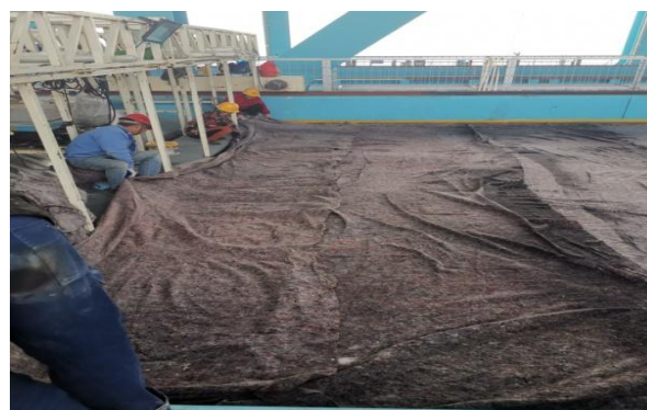
图 10 UHPC 覆盖土工布养护
