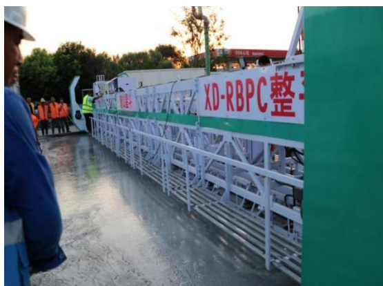
图 7 UHPC 现场摊铺整平
