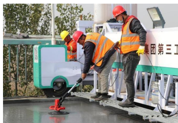
图 8 UHPC 人工收面
