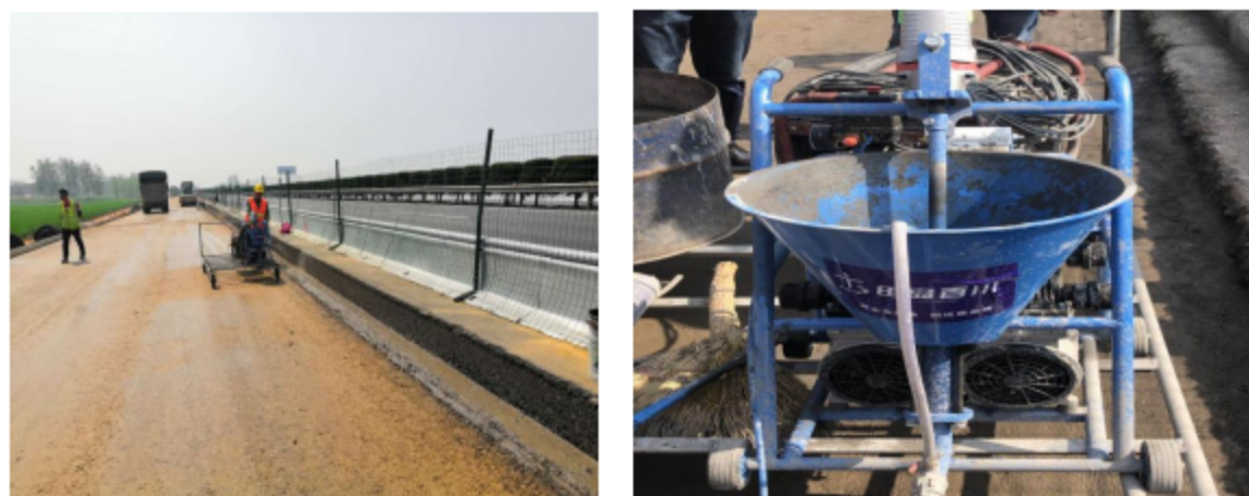
图 1 台阶喷洒水泥净浆
